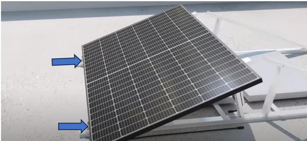
Im nächsten Schritt montieren Sie die Endklemmen an der oberen Seite des Dreieckes / Solar-Moduls
